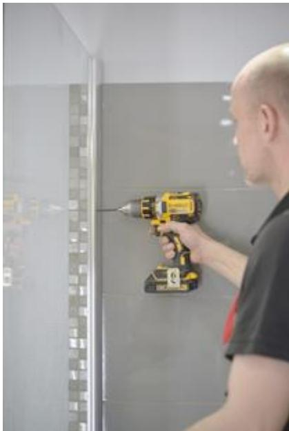
Nach Ausrichtung der Glasscheibe, Befestigungslöcher bohren und mit den mitgelieferten Schrauben befestigen.
